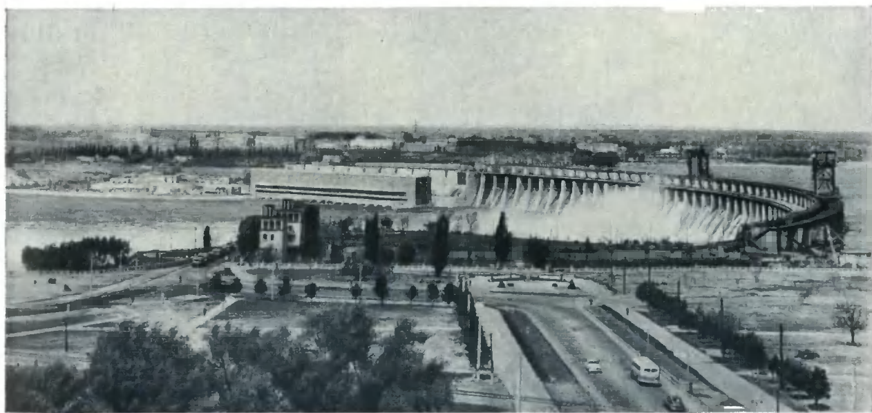
Первенец плана ГОЭЛРО — Волховская гидроэлектростанция ( сверху ); Днепровская гидроэлектростанция имени В. И. Ленина (Запорожская область)
